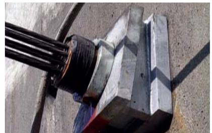
**FORMA DE TESADO** - Las cabezas estándares MeKano4 para anclajes temporales y permanentes pueden tensarse con gatos Arrow, MS1, MS2, MS3.
